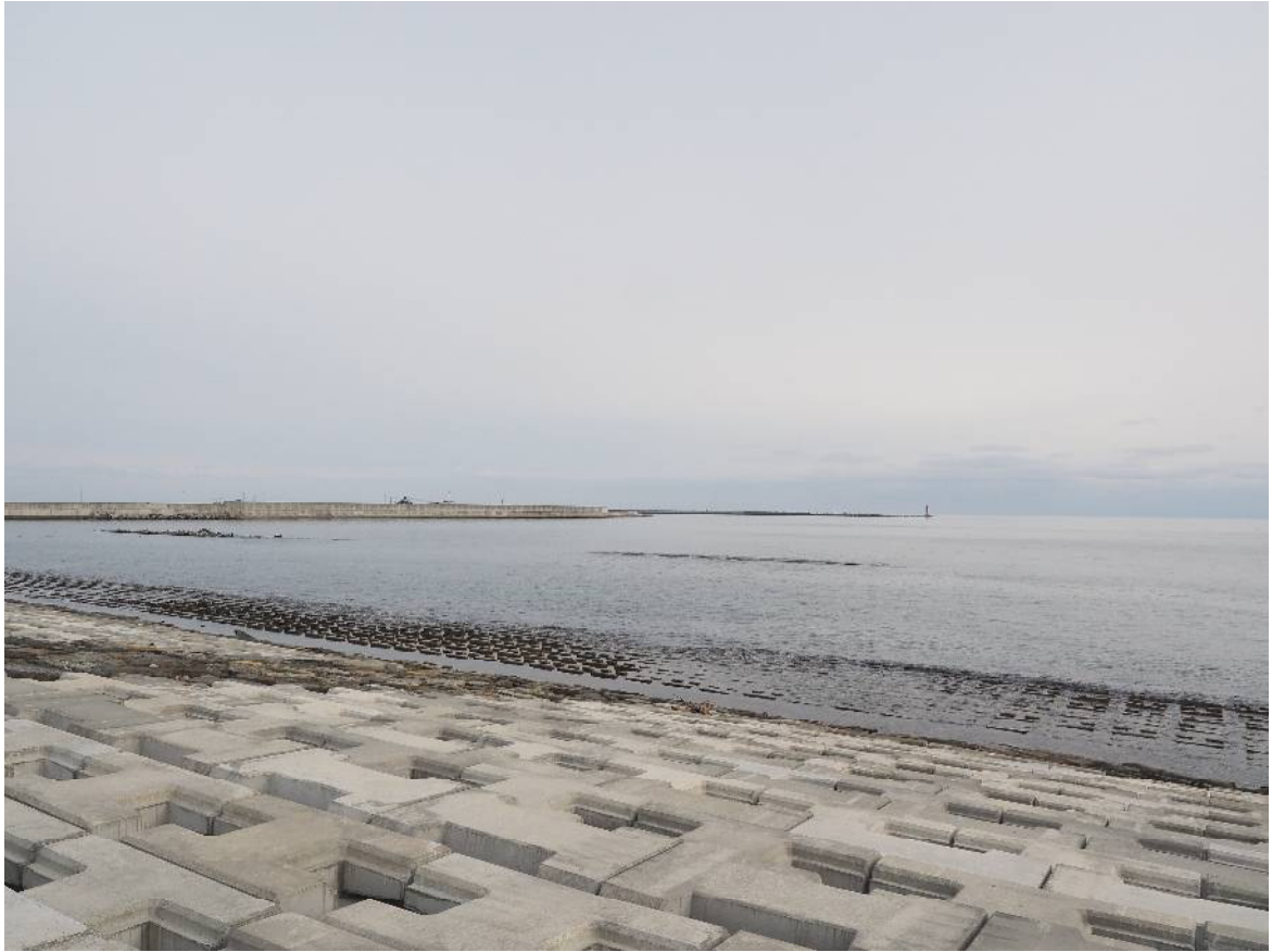
萩野・北吉原地区緩傾斜護岸
